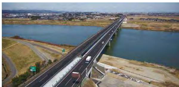
4車線化後の阿武隈大橋
