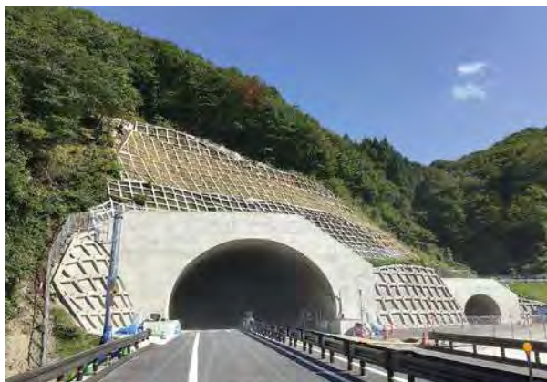
新区界トンネル 盛岡側坑口
