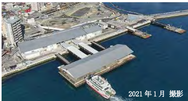
2021年1月撮影 宮島口整備状況
