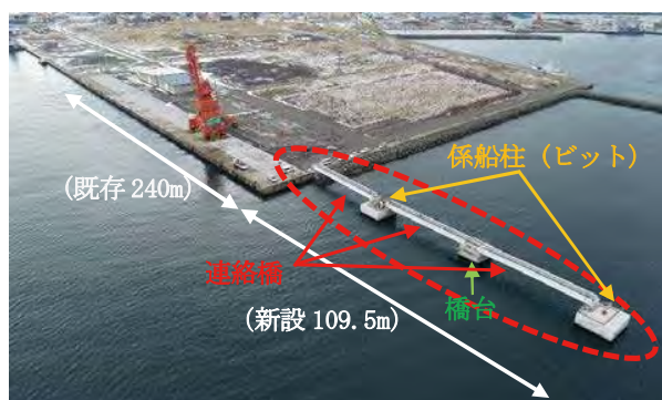
係留ピット完成状況
