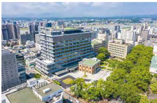
防災庁舎・県庁5号館外観
