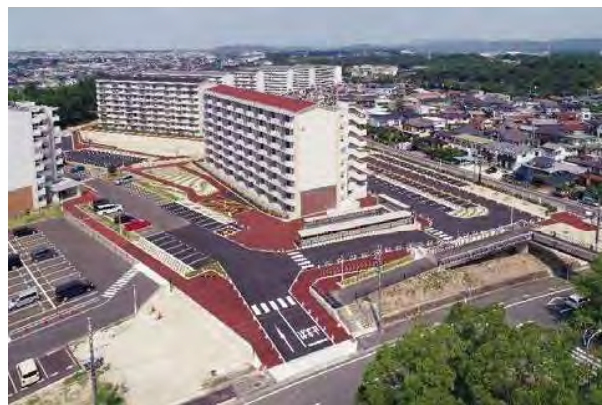
建替後の原山台住宅（7丁目）
