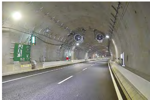
横浜北西トンネル
