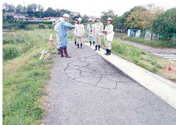
不具合堤防での講習状況
