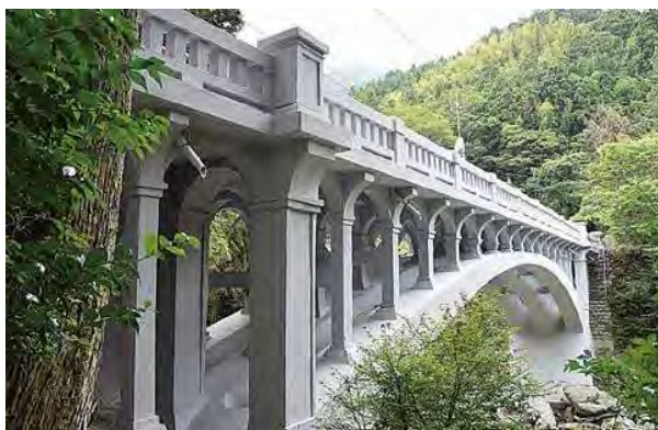
修繕後の大宮橋
