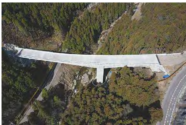
一級河川段戸川を横断する新郡界橋
