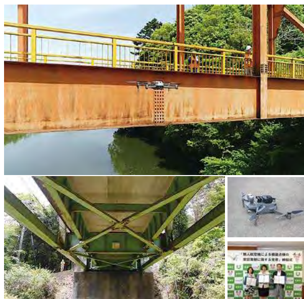
ドローンを活用した橋梁点検の様子
