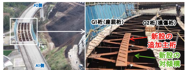
新設主桁の追加設置状況
