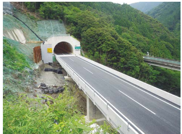
高知自動車道（立川橋）復旧状況
