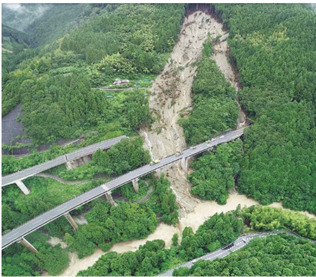
高知自動車道（立川橋）の被災状況
