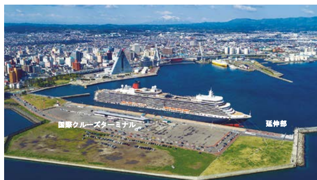
延伸後の利用状況
