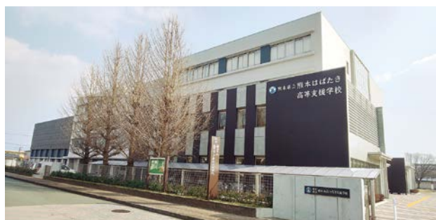
鉄筋コンクリート造（一部鉄骨鉄筋コンクリート造）4階建て 建築面積 3,240㎡ 延床面積 8,749㎡
