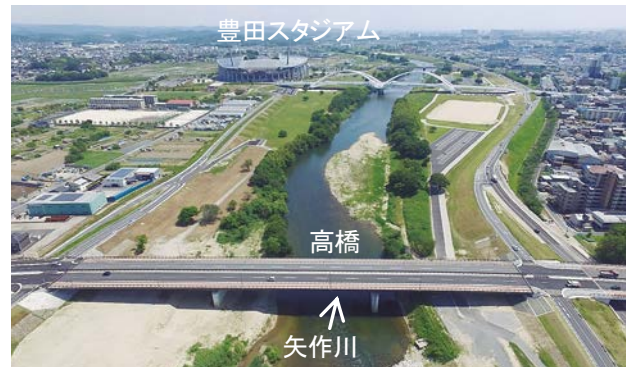
「高橋」4車線完成
