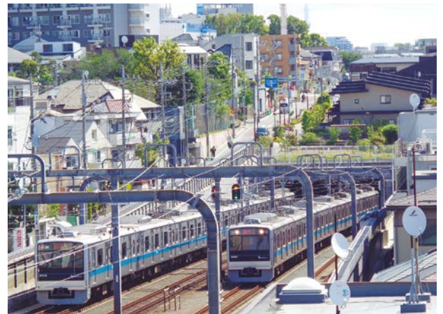
事業完了後状況(世田谷代田駅～梅ヶ丘駅間)
