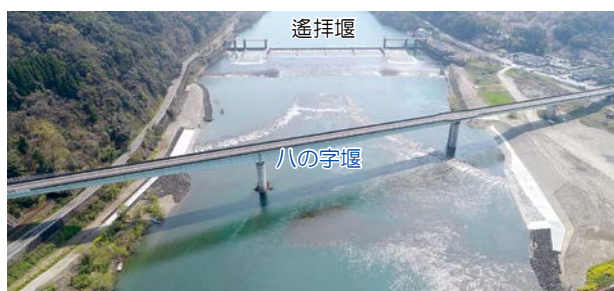
完成した八の字堰
