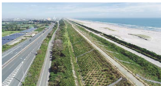
竣工した防潮堤
