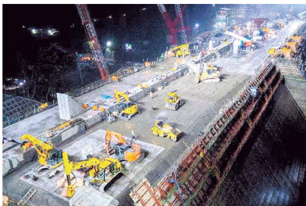
巡航RCD工法 施工状況
