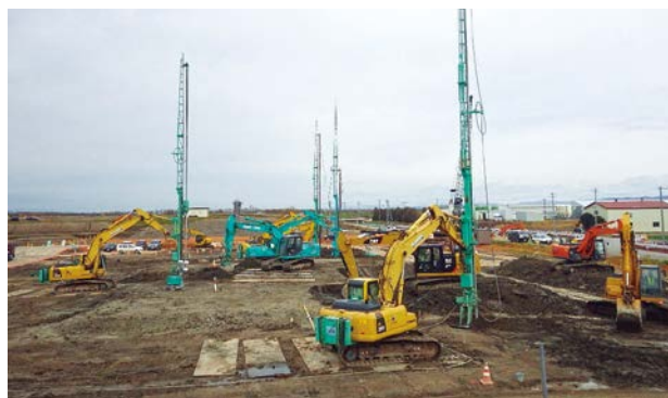
地盤強度増強のための深層混合処理工法
