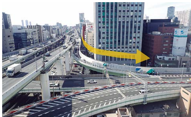
渡り線完成後の西船場JCT（東側上空より）
