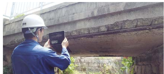
自治体職員による点検状況
