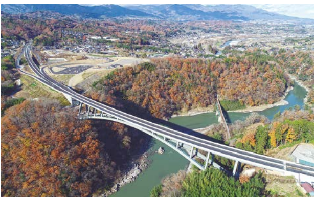
天龍峡大橋の全景（天竜川下流より）
