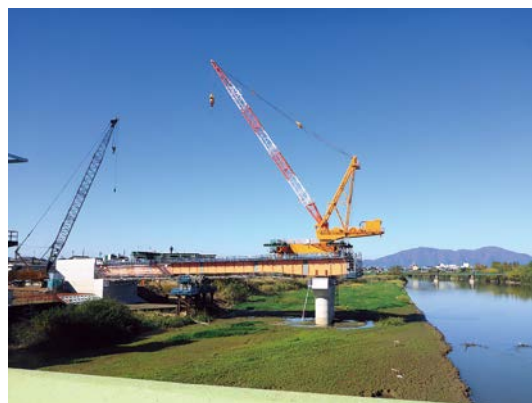
トラベラークレーンを用いた上部工工事
