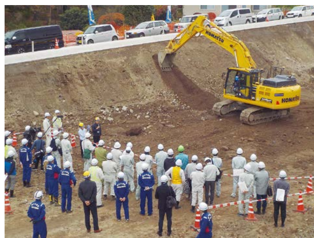
ICT土工研修会の様子
