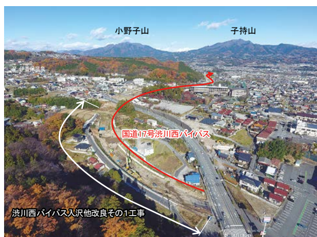
国道17号渋川西BP及び工事の状況
