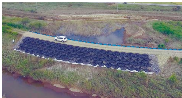
補強のための護岸完了状況
