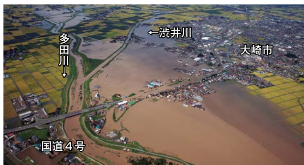
渋井川の氾濫状況
