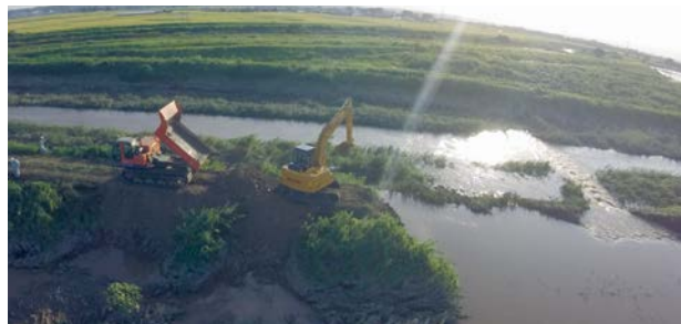
決壊箇所の復旧状況
