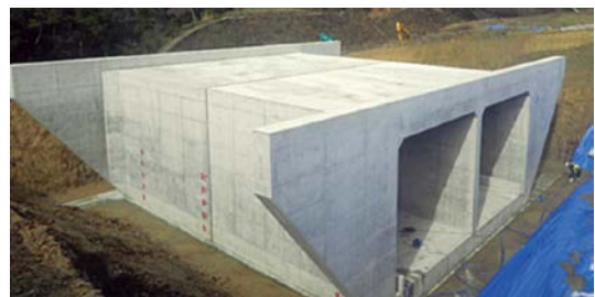
規格外瓦骨材を使用した函渠
