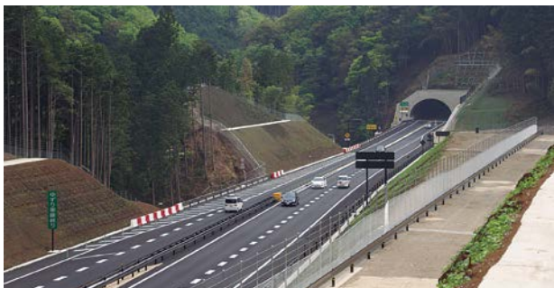
完成した八鹿日高道路
