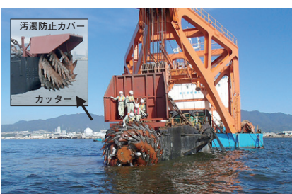
ポンプ浚渫船（船首部）の現場施工写真
