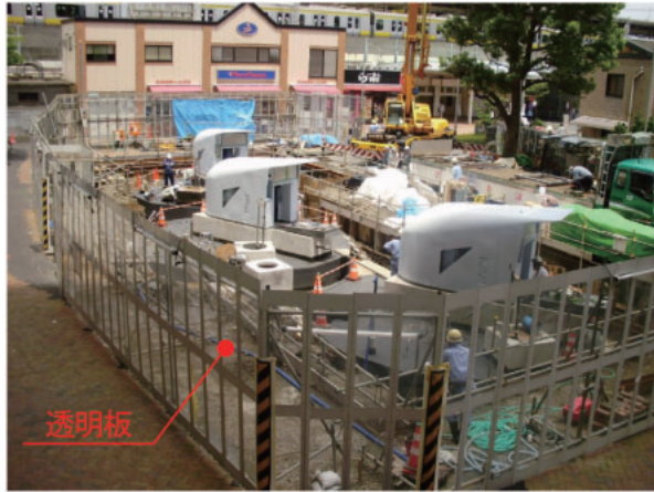
安全甲板設置
