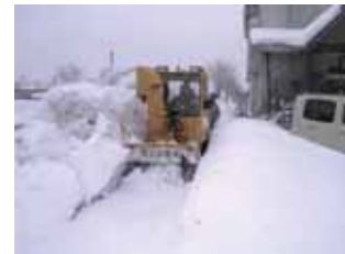
歩道除雪作業
