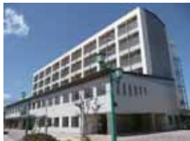
建物を南東から
