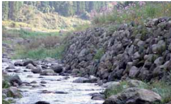
完成後の様子
