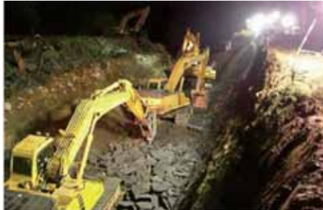
24時間体制で仮排水路を掘削
