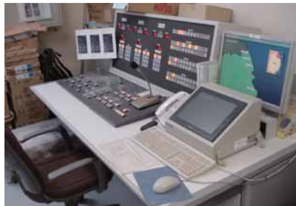
津波防災ステーション
