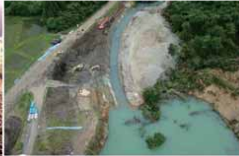
通水した市野々原地区
