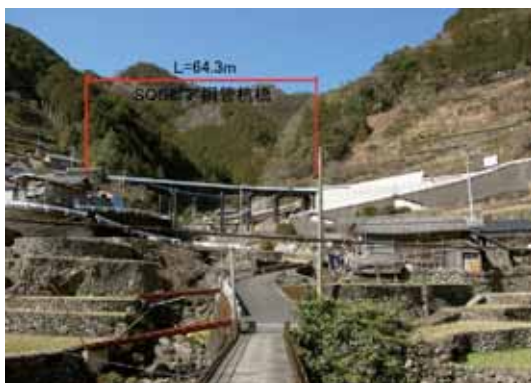
SQCピア鋼管杭橋
