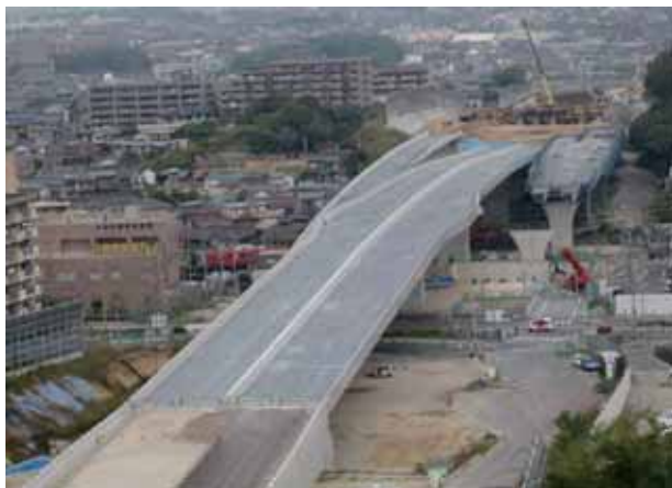
有松高架橋終点側より
