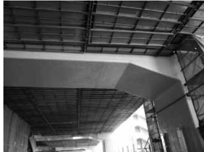
橋脚補修完了
