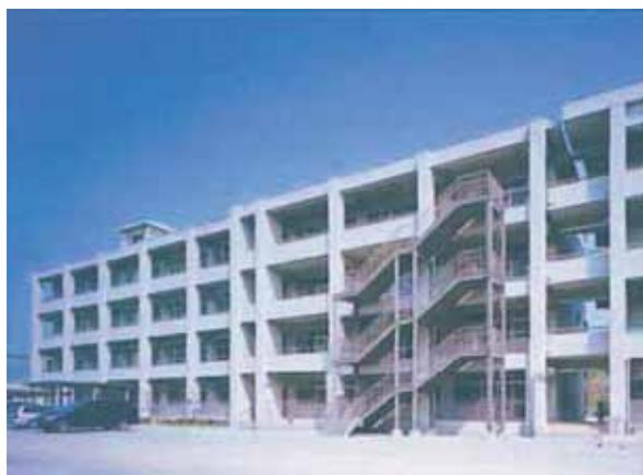
RC外郭フレームによる補強
