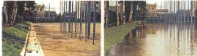
平常時 貯留時 地表式貯留施設
