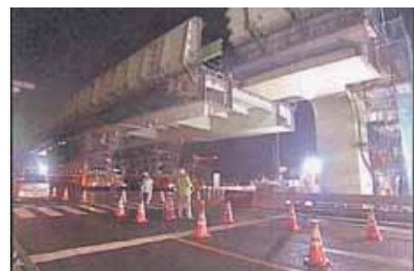
新保高架橋 交差点直上部の移動多軸台車による一括架設 (H19.7撮影)
