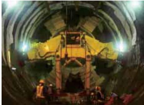
リーミングTBMの組立状況(φ12m)
