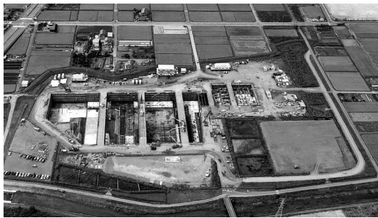
上空から見た建設現場
