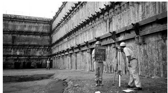
建設現場内部（GL - 13.5m）
