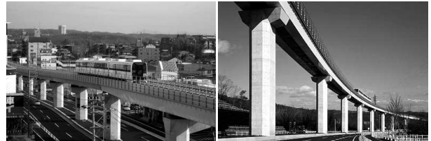
リニモ走行状況
