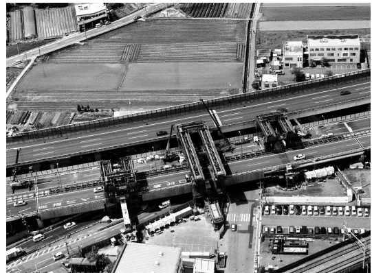
横梁架替工事全景
