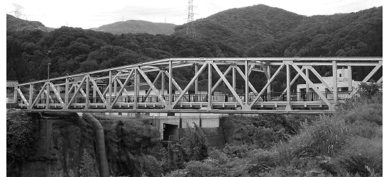
再利用材で建設された金名橋
