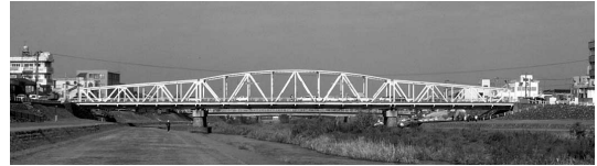
解体される前の御影大橋
