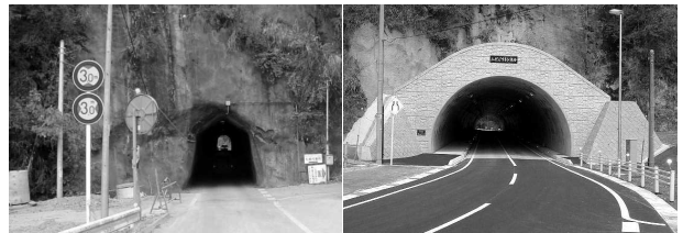
施工前（札郷隧道）
