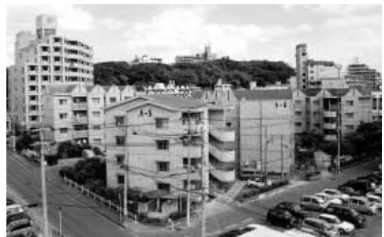
住宅地区改良事業によって整備された街区
