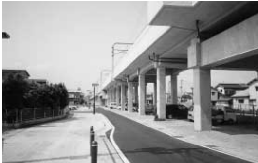
側道整備状況
