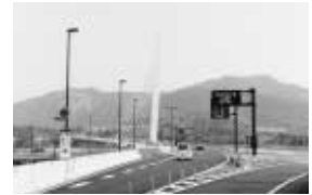
鵜飼い大橋左岸側から主塔を望む
