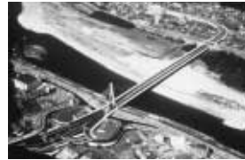
鵜飼い大橋上空から主塔を望む
