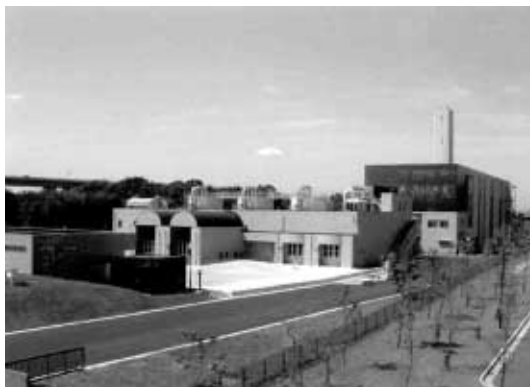
栃木県下水道資源化工場の全景
